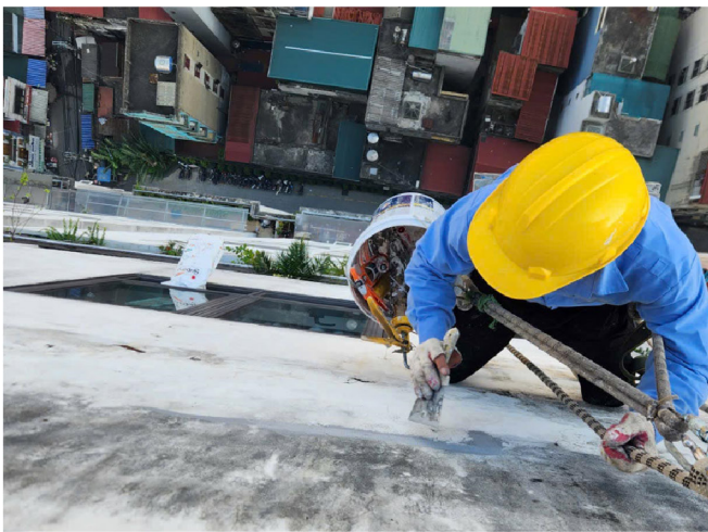
Xử lý chống thấm vết nứt mặt ngoài tòa nhà.
