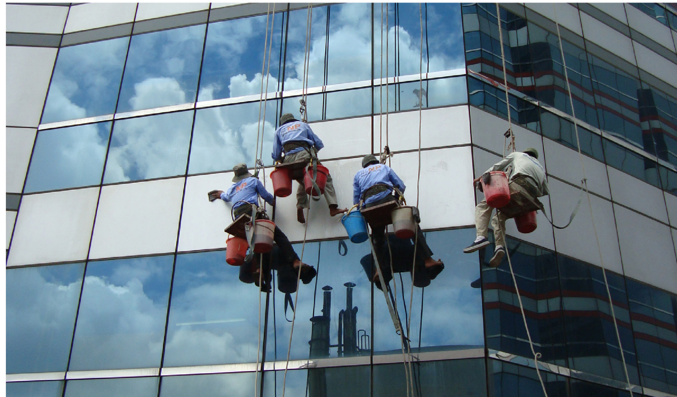
Bơm keo chống thấm vách kính tòa nhà cao tầng.
