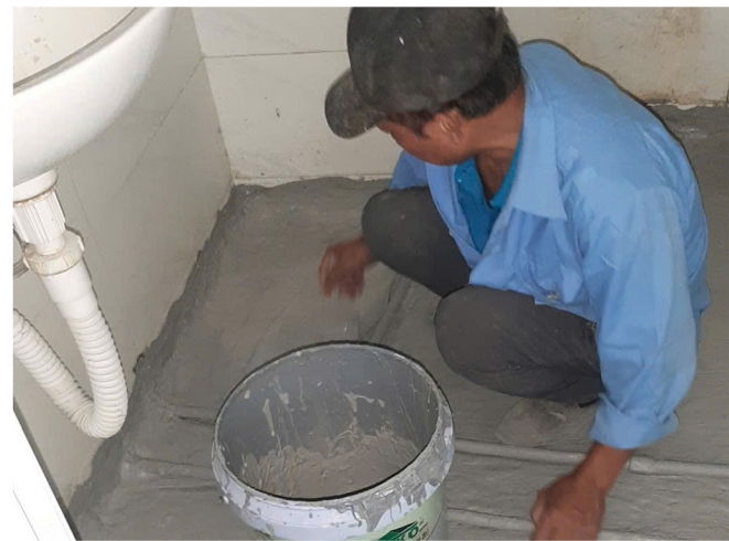
Xử lý chống thấm dột trần, tường, khu vệ sinh.
