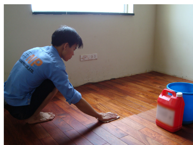
Bảo dưỡng, phủ bóng sàn gỗ công nghiệp.
