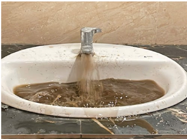
Sục rửa đường ống nước sinh hoạt
