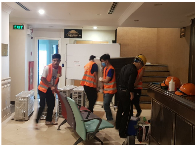
Tổng vệ sinh sau xây dựng
