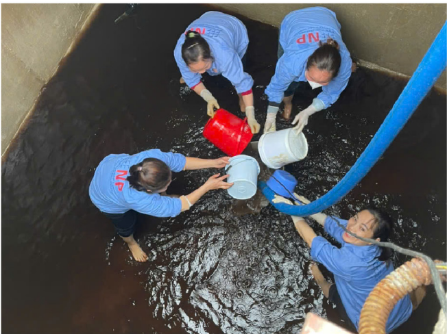
Làm sạch bể nước sinh hoạt
