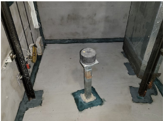
Xử lý chống thấm ngược cho Hồ thang máy.
