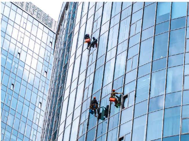
Lau kính Toà nhà Cao tầng
